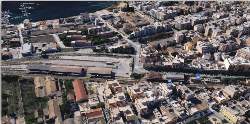
Stazione Ferroviaria – Marsala - area Deposito Merci
