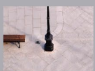
Pavimentazione in pietra naturale di colore chiaro con note di disegno diverse a dividere gli spazi in Piazza dei Partigiani a Naxos
